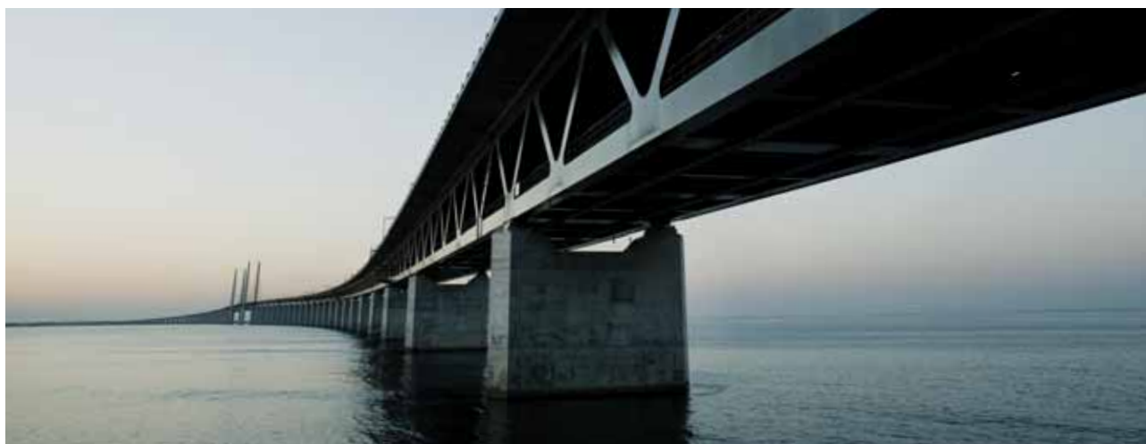
Järnvägsdäcket under motorvägen.
