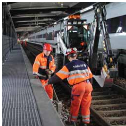
Underhåll av järnvägsspår på bron.
