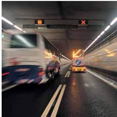
Underhållsarbete i tunneln.
