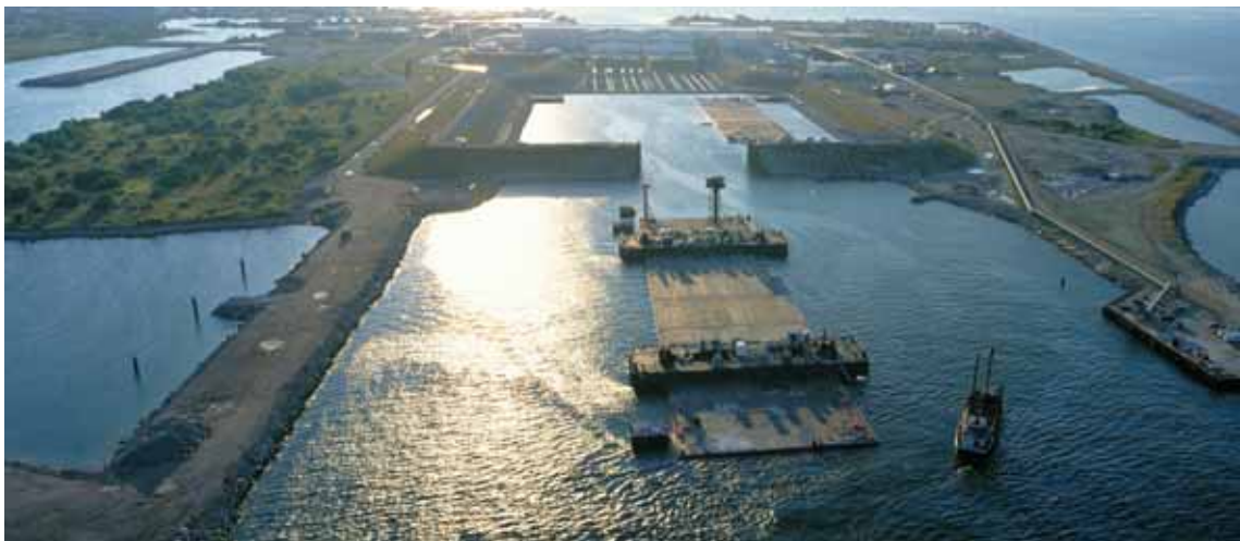
Första tunnelelementet bogseras från fabriken i Köpenhamns Nordhavn.
