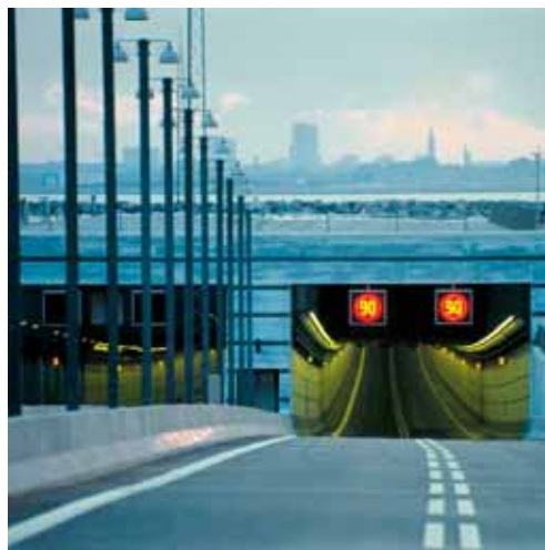
Tunnelnedfarten på Peberholm.
