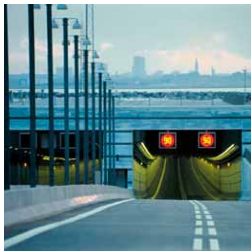
Tunnelnedkørsel på Peberholm.
