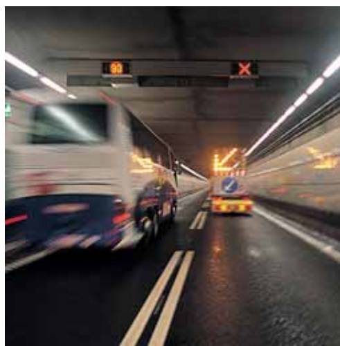
Vedligeholdelsesarbejde i tunnelen.
