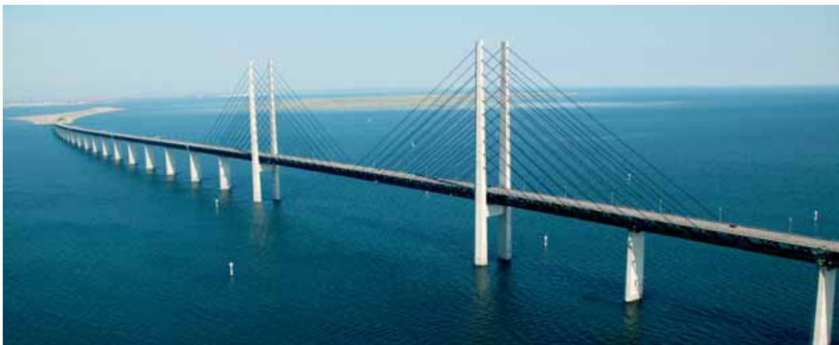
Vestlig tilslutningsbro og højbro.
